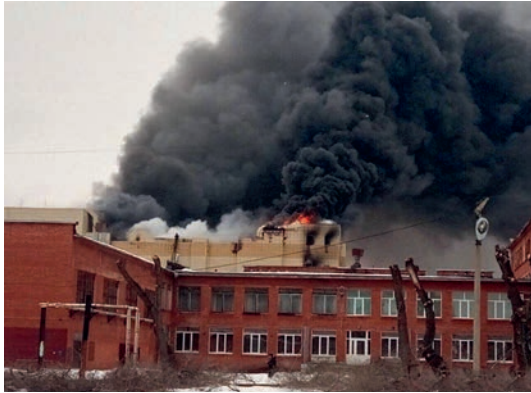
Горение кровли в ТРЦ «Зимняя вишня»
