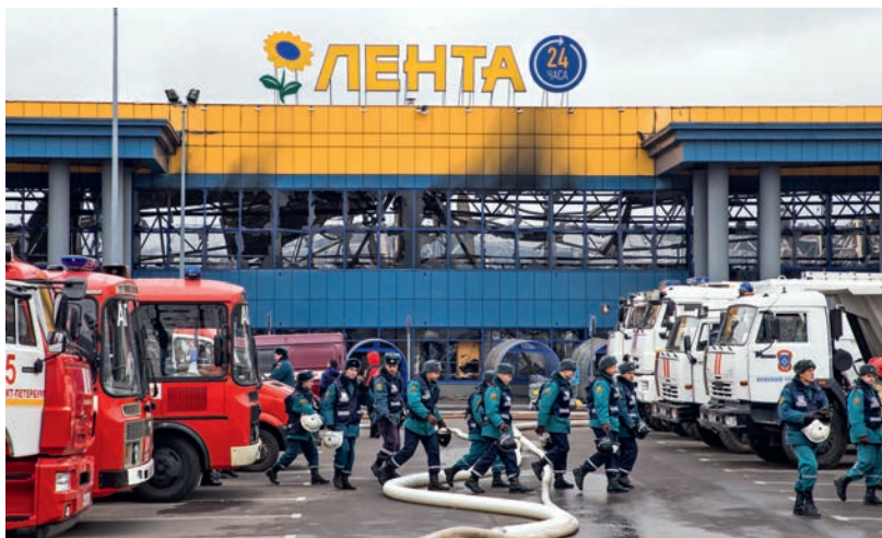
Пожар в ТЦ «Лента», г. Санкт-Петербург
